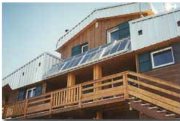
Exemple d'un équipement photovoltaïque : refuge de Bésines (Hautes Pyrénées)
