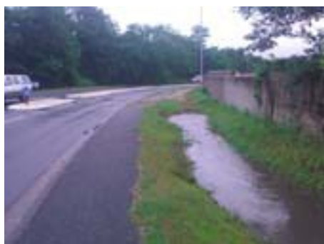
Fossé rue de la pouidière
